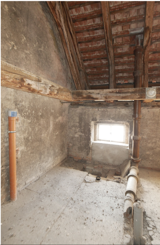
PROSTOR PODKROVÍ NAD BYTEM vyústění odvětrání dvou kanalizačních stoupaček porušené odkouření plynového spotřebiče
