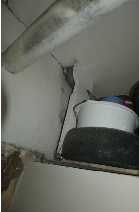
MÍSTNOST 07 prostor společných záchodů s odděleným WC bytu přízděné vedení kanalizační stoupačky a vody nahore je ozinkocementová roura odvětrání koupelny
